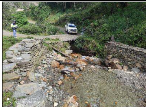
Figura 02. Se muestra un pequeño puente rústico sobre el cauce de la quebrada, rodeado de estructuras de piedra. Se identifican zonas potencialmente vulnerables a desbordamientos durante crecidas, especialmente en los márgenes donde la protección lateral es baja, así como en la base del puente, donde podrían acumularse sedimentos y obstrucciones. La infraestructura adyacente, como la vía y muros de contención, está expuesta a posibles socavaciones.
